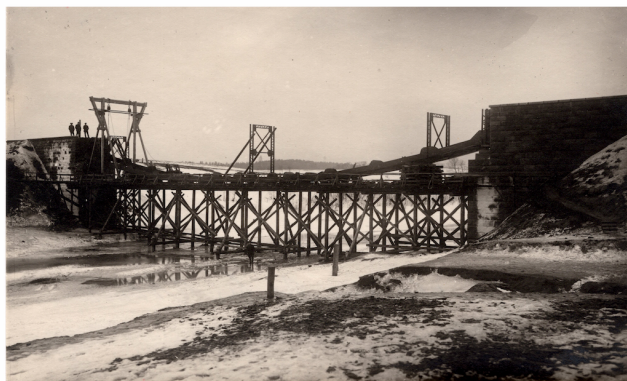
Valmieras šaursliežu dzelzceļa tilta celtniecības sākums pār Gauju
